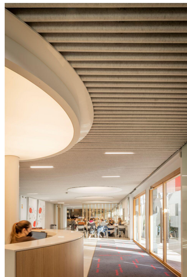
P2 FAUX PLAFOND ACCOUSTIQUE LAMES FEUTRE TYPE HEARTFELT LINEAR DE HUNTER DOUGLAS SUR OSSATURE SUPPORT
